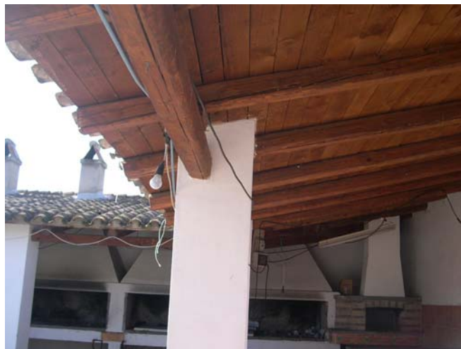
foto n. 5 (particolare copertura area realizzazione sgombero)
