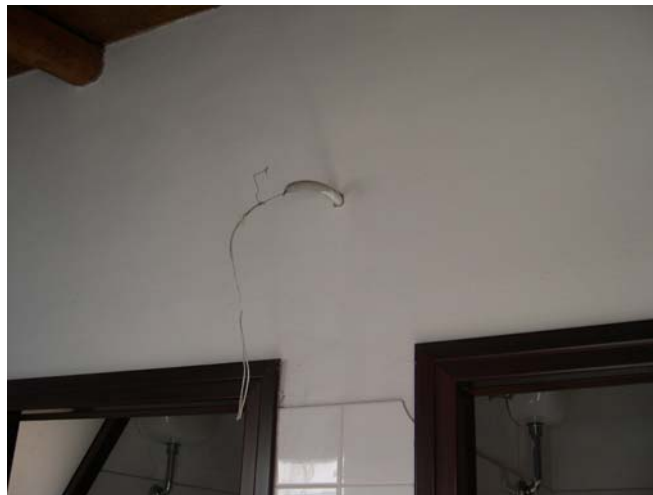
foto n. 2 (particolare cavidotto esistente – servizi igienici )
