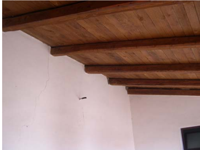
foto n. 1 (particolare cavidotto esistente – porticato)
